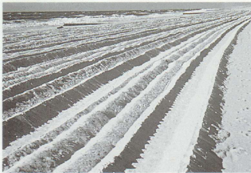
19/20 Fräse zum Versenken der technisch nicht mehr weiter zu beseitigenden Rückstände einer Ölpest auf Sylt. Gemulchter Sandstrand.
