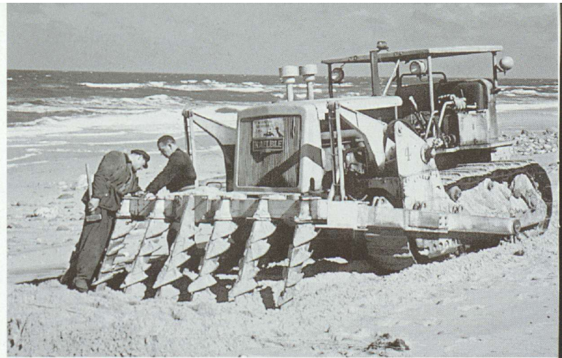
19/20 Fräse zum Versenken der technisch nicht mehr weiter zu beseitigenden Rückstände einer Ölpest auf Sylt. Gemulchter Sandstrand.
